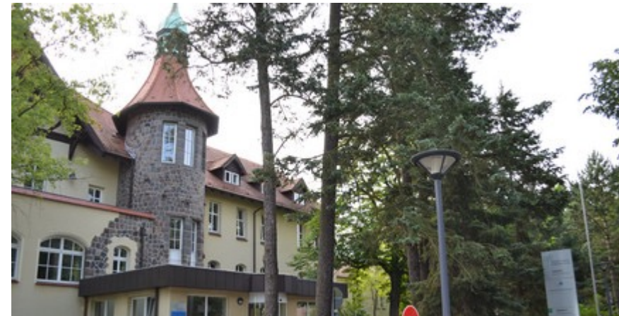
Institut für Ernährungswissenschaft (Rehbrücke)
